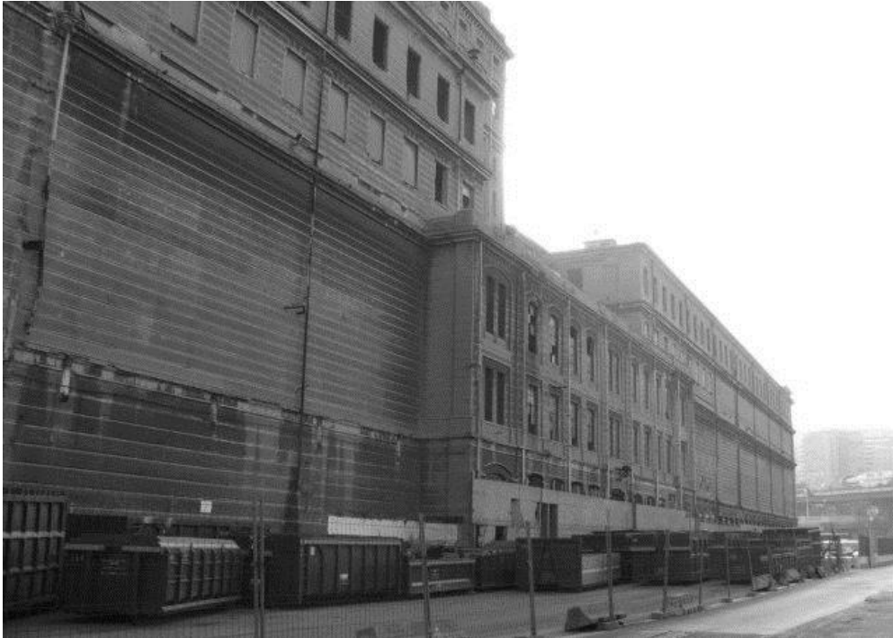
Figura 7. Silos de concreto armado atribuídos a François Hennebique. Fonte: Foto da autora
