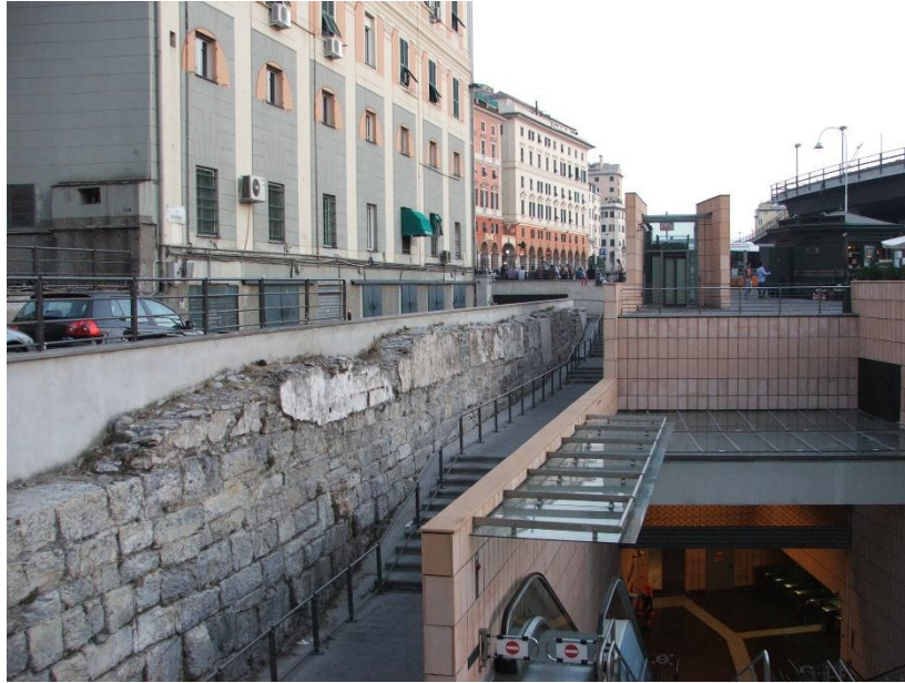
Figura 8. Entrada da Estação San Giorgio. Parte da estrutura de pedra das antigas plataformas
