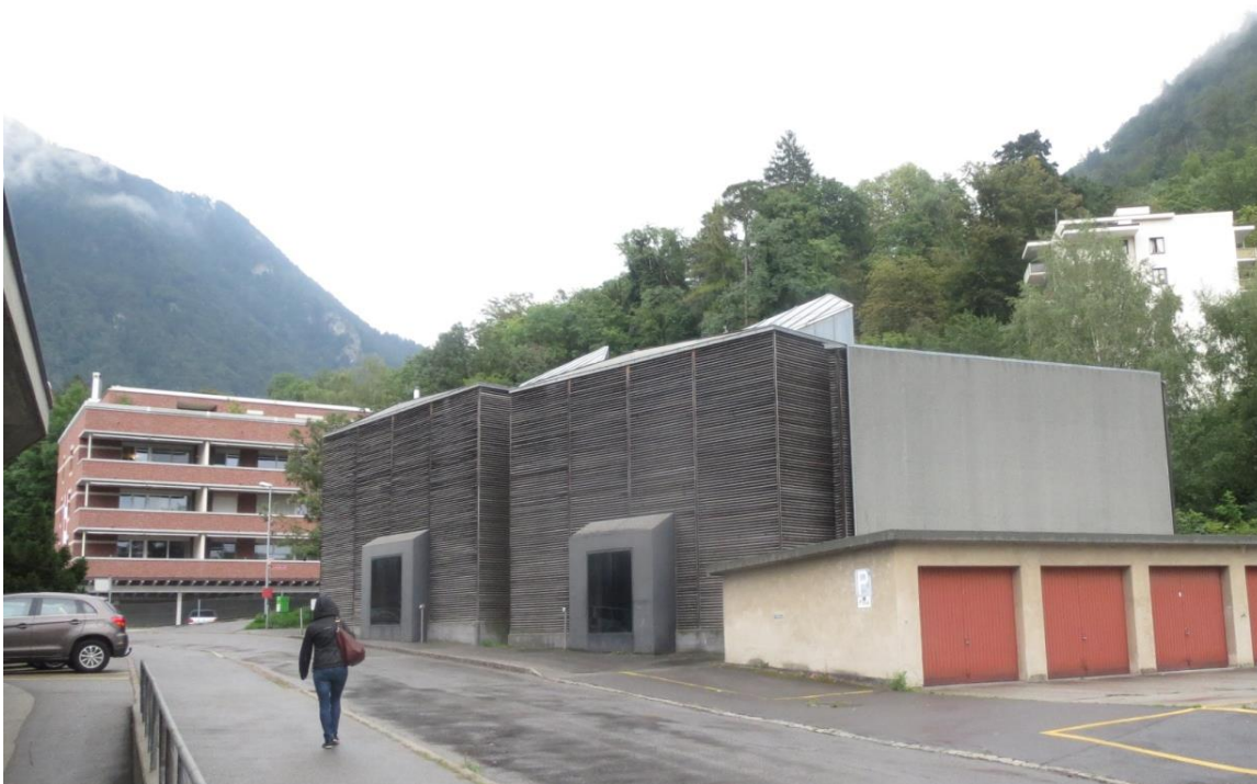
Figura 9 – Abrigos em Chur, Suíça: nova volumetria formada por lâminas de madeira dispostas intercaladamente que deixam penetrar luz, ar e umidade essencial para a proteção e exposição das ruínas romanas. Fonte: Foto elaborada pela autora, 2014.
