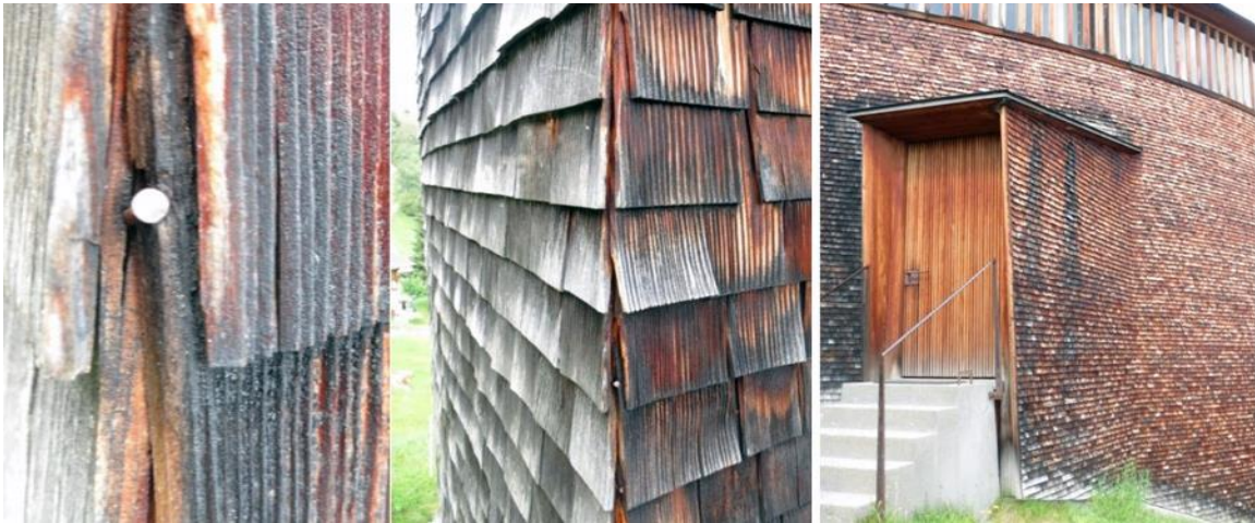
Figura 19 - Capela Sogn Benedetg: sistema estrutural e o tratamento das superfícies externas do edifício usando Schindel , tradição construtiva local.
