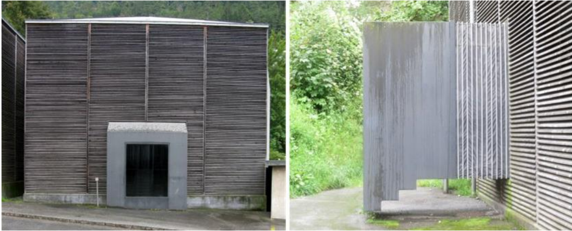
Figura 11 – Abrigos de proteção para ruínas romanas Chur, Suíça: e) Vitrine para a rua cuja configuração segue a linha das fundações reveladas na arqueologia; d) Entrada do Museu que dá acesso direto às passarelas de visitação. Fonte: Fotos elaboradas pela autora, 2014.
