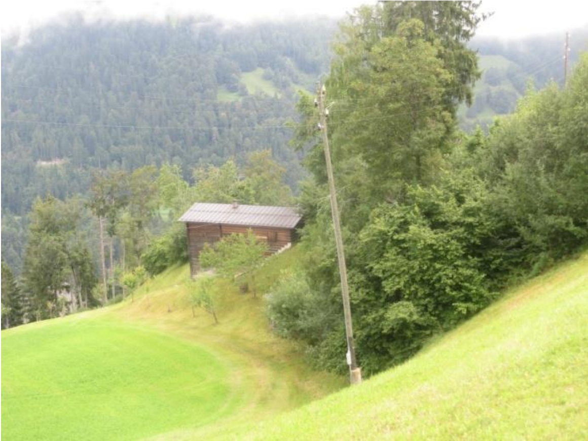
Figura 2 – Gugalin Haus , Vale do Safien: velha estrutura trazida de volta à vida, à paisagem e ao tempo presente por um projeto de intervenção sensível à qualidade e história do lugar. Fonte: Foto elaborada pela autora, 2014.
