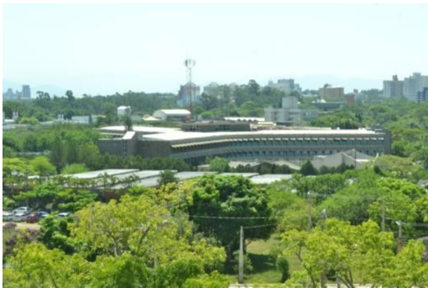
Figura 13 - Edifício da Telesc atualmente.
