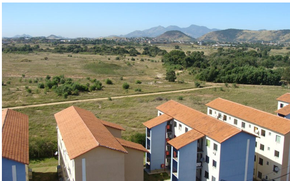
Figura 2 - Ocupação nas cercanias dos condomínios.
