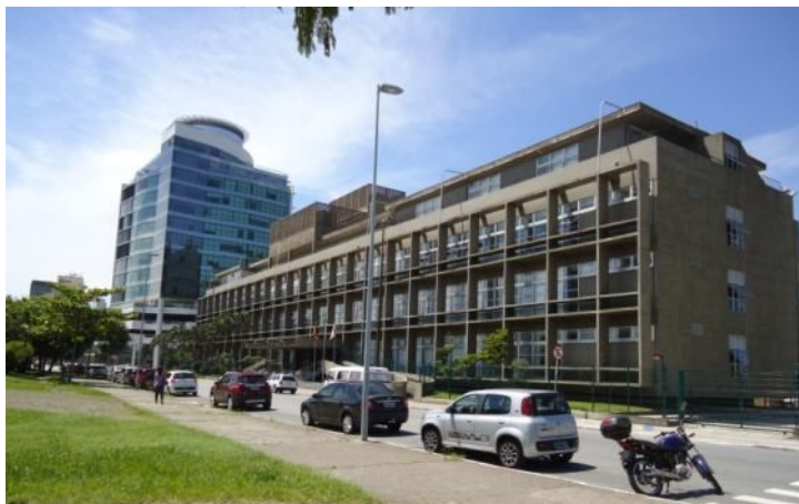
Figura 11 - Edifício do Palácio de Santa Catarina atualmente. Fonte: Acervo da Pesquisa Itinerários da Arquitetura Moderna, 2014.
