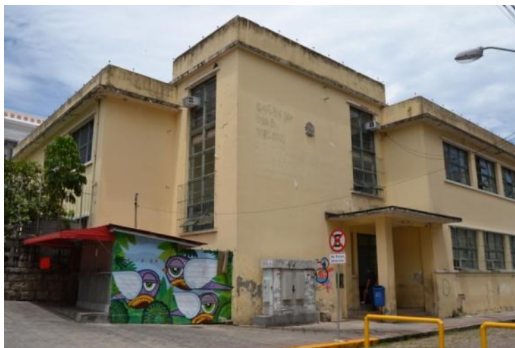
Figura 5 - Edifício do Colégio Estadual Dias Velho em foto atual. Fonte: Acervo da Pesquisa Itinerários da Arquitetura Moderna, 2014.
