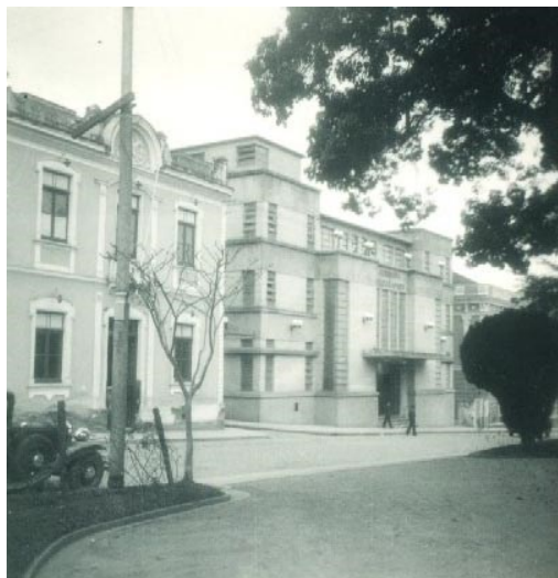
Figura 2 - Edifício dos Correios e Telégrafos no ano de 1934. Fonte: Cartão postal. Acervo do Arquivo da Casa da Memória, FFC.
