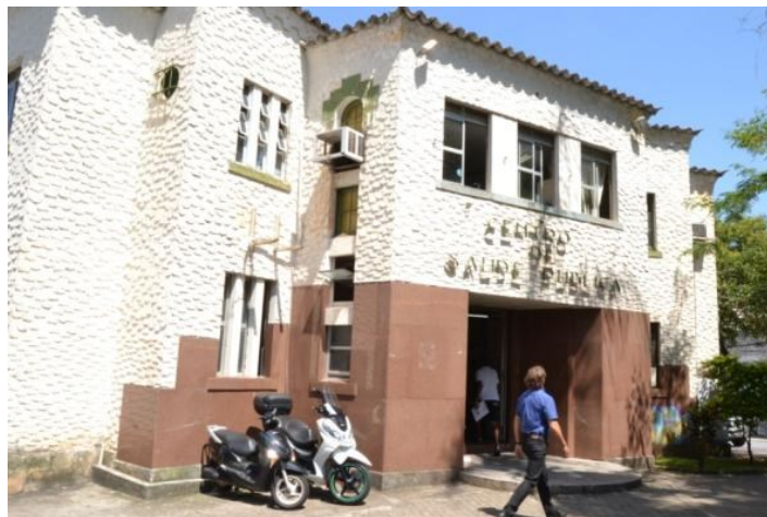
Figura 4 - Edifício do Departamento de Saúde Pública em foto atual. Fonte: Acervo da Pesquisa Itinerários da Arquitetura Moderna, 2014.
