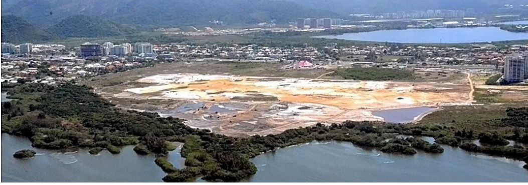
Figura 10 e 11 – Perspectiva da área após a implantação do campo de golfe (em simulação) e foto aérea da mesma área após a retirada da vegetação, para o início da construção do campo de golfe olímpico (2014).
