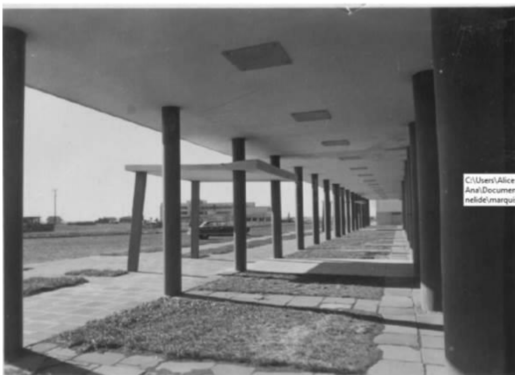
Figura 10 - Pilotis e marquise de acesso ao Ed. Stella Maris, um dos primeiros edifícios residenciais construído junto à Avenida Central - anos 1950.
