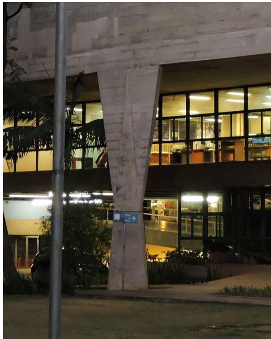
Figura 11 – Detalhe do pilar em forma de triângulo invertido que sustenta a caixa de concreto. Fonte: Samantha Palma (2016).
