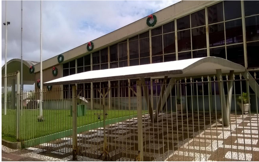
Figura 5 – Detalhe da marquise e pilares em “V”. Fonte: Samantha Palma (2016)
